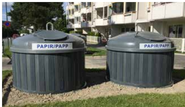
Avfallssystem med forskjellige innkast
