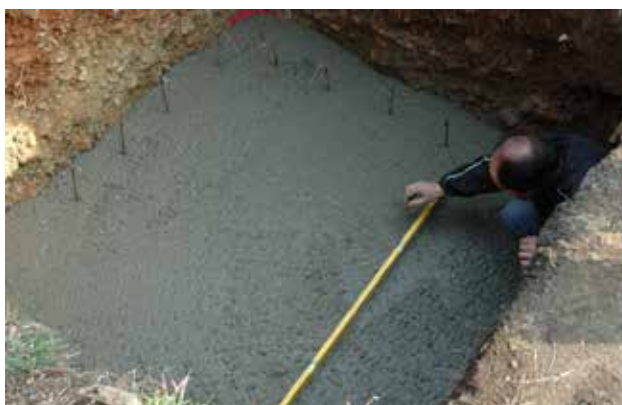
Hullet klargjøres med betongunderlag eller annet stabilt underlag.
