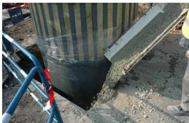
Hullet fylles med pukk.
