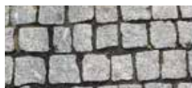
Brostein lagt i samme mønster som eksisterende belegg
