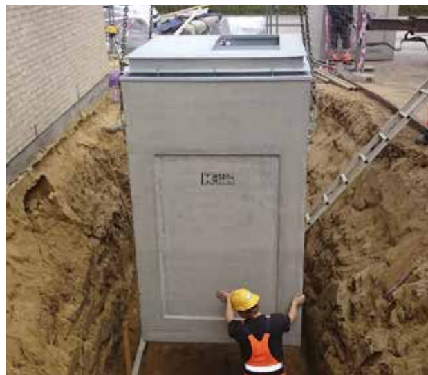
Betongcontaineren plasseres i et ferdig hull i bakken.
